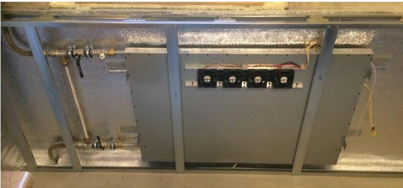
Рис. 1. Пример одного из вариантов возможного изготовления нагревательного устройства закрытого типа
