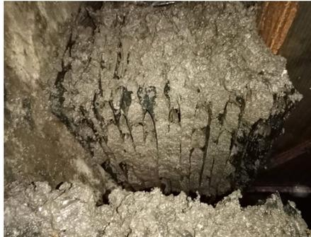
Рис. 2. Забитые осадком тонкослойные модули во вторичных отстойниках
