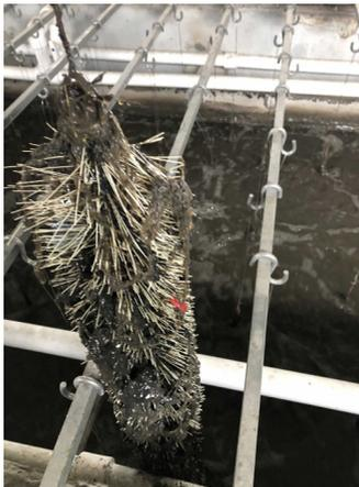
Рис. 3. Загнивающая биопленка на ершовой биозагрузке
